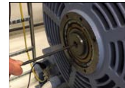
Måling av motorens lagerspenning i ventilatorenden.
